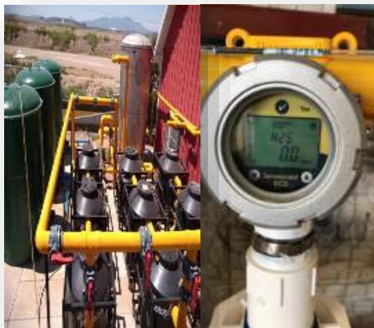
Fig. 1 Sistema de filtrado.
